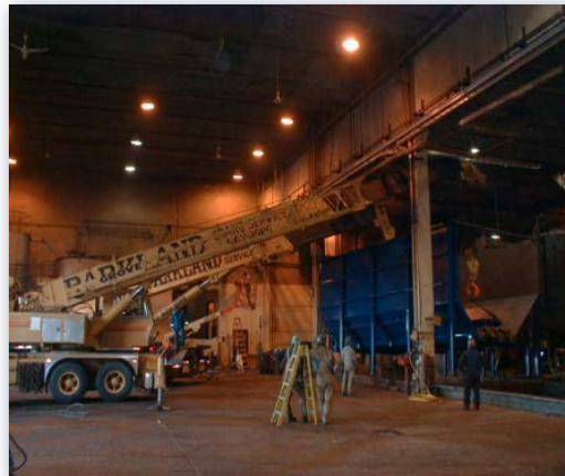
установка приемного бункера
