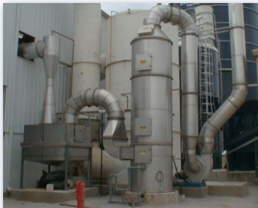
3-я стадия промышленного процесса переработки: скруббер
